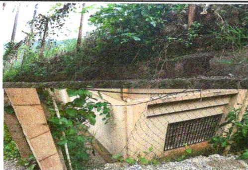
Foto 5: Muro perimetral con block y malla en malas condiciones
