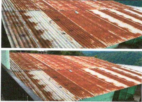
Foto1: Lámina de módulo de aula en malas condiciones con varias goteras en lluvia
