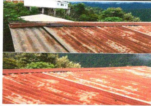
Foto 2: Capotes en malas condiciones ingresa agua en lluvia
