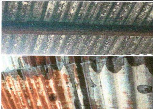
Foto 3: Elementos de fijación con poca presión para apretar
