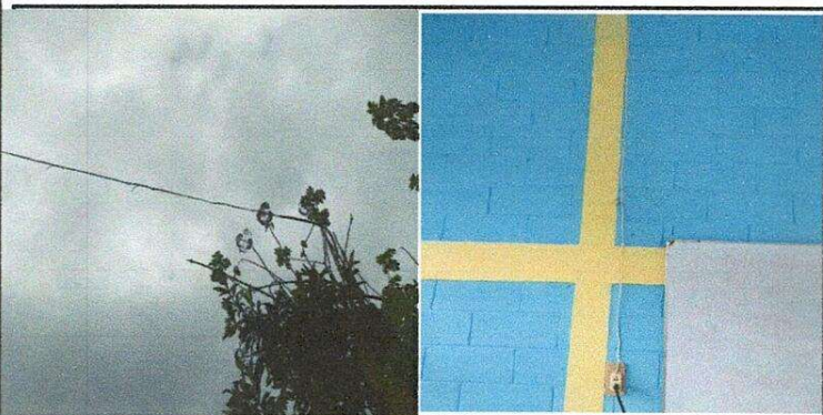
Foto 3: Se evidencia la sustitución del cable y la nueva instalación para tomacorrientes
