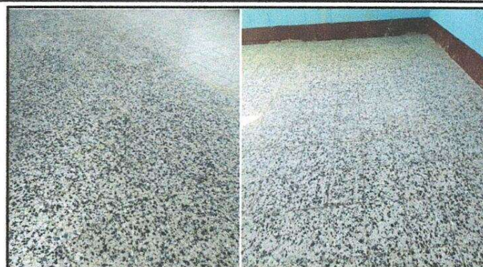
Foto 2: Evidencia de la sustitución de piso en otras aulas.
