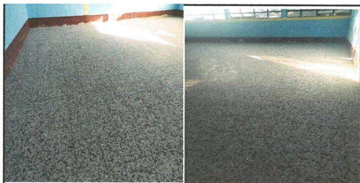
Foto 3: Otras aulas con el piso sustituido
