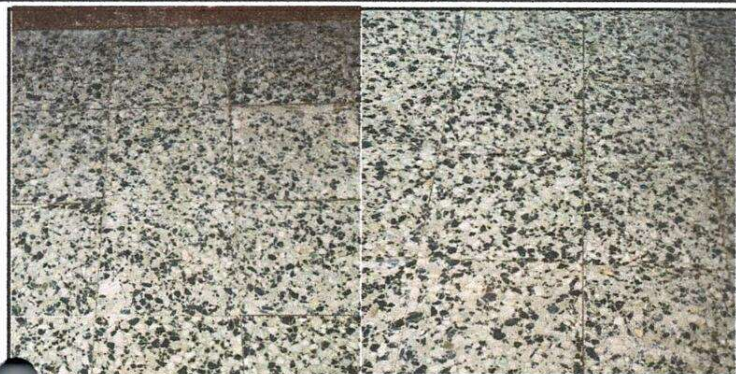
Foto 1: Evidencia de la sustitución de piso
