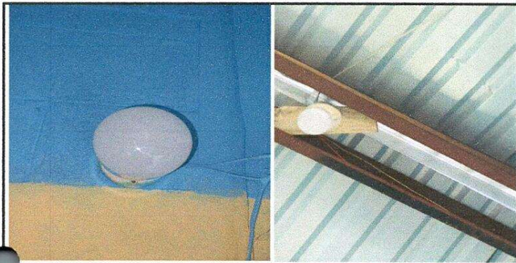
Foto 1: Se evidencia el cambio de lámparas led
