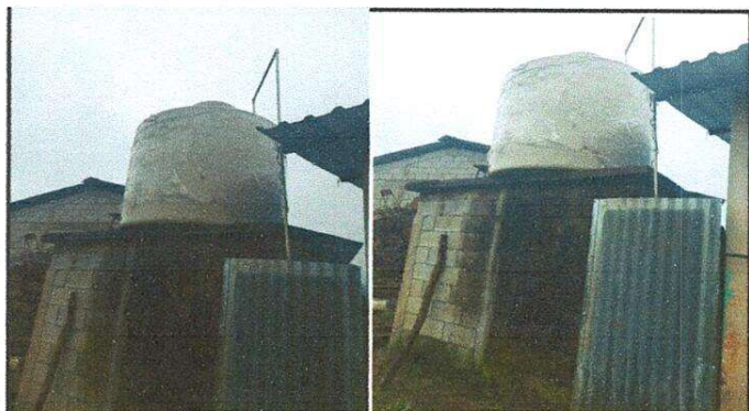
Foto 4: Se evidencia la instalación finalizada del tinaco
