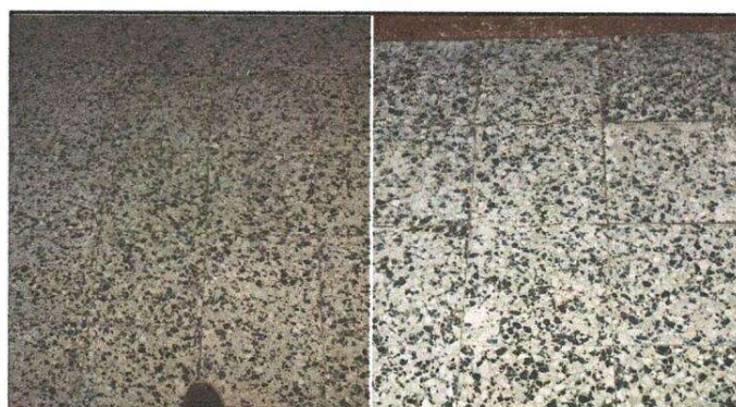
Foto 4: Otras aulas con el piso nuevo
