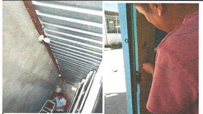
Foto 2: Se evidencia la instalación de interruptores, tomacorrientes y lámparas.
