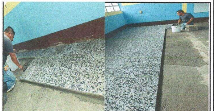
Foto 6: Se evidencia el inicio de la colocación de piso granito
