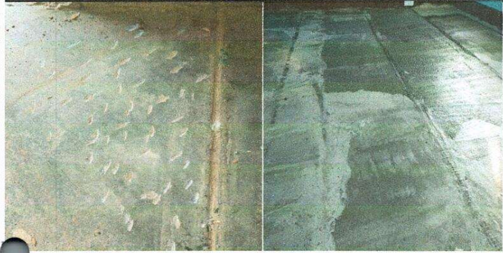
Foto 1: Iniciando el trabajo para sustituir el piso
