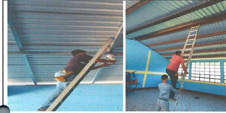
Foto 1: Se evidencia el trabajo en la reparación e instalación
