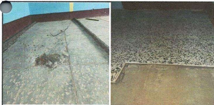
Foto 5: Nivelación de piso en unas aulas e inicio del piso granito en otras
