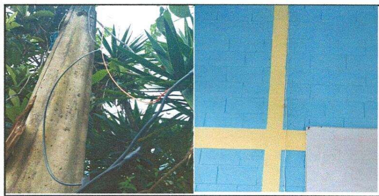
Foto 3: Se evidencia la instalación y reparación de cableado eléctrico
