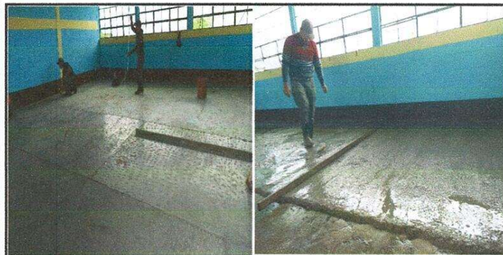
Foto 3: Evidencias del trabajo en la nivelación de piso, para despues poder colocar el piso granito
