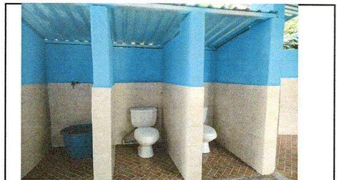
Foto 4: Reparación de servicios sanitarios
