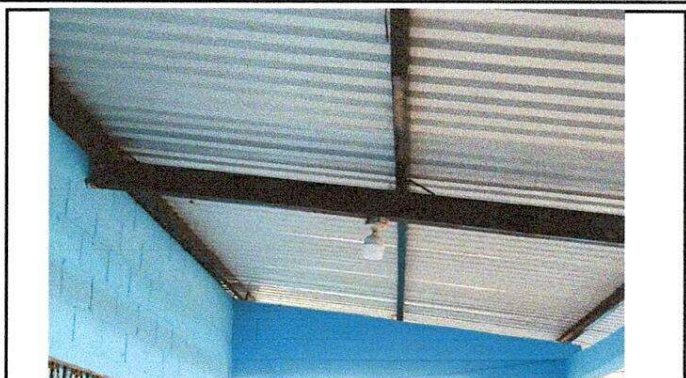
Foto 8: Sustitucioin de sistema eléctrico
