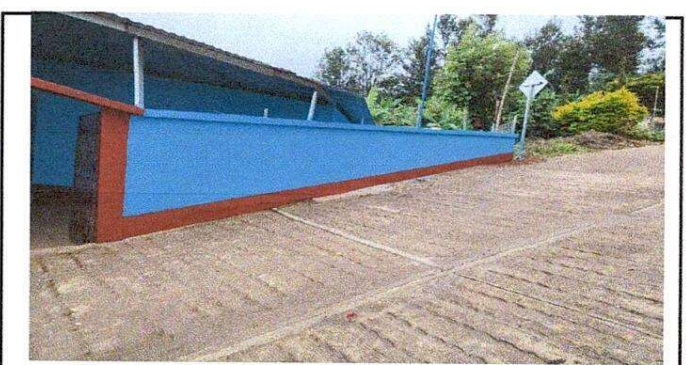
Foto 6: Sustitución de pintura en muro exterior
