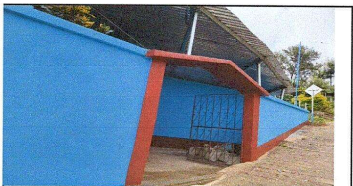
Foto 5: Sustitución de pintura en muro exterior
