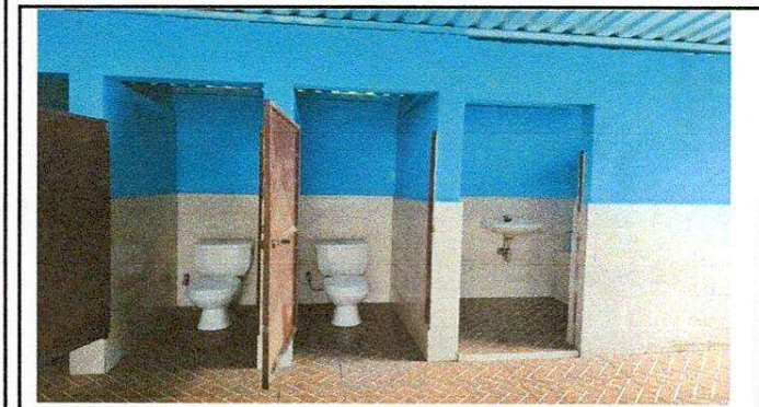
Foto 3: Reparación de servicios sanitarios
