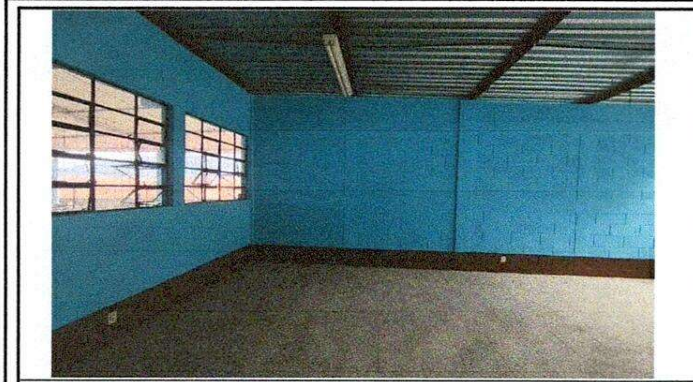
Foto1: Sustitución de piso de torta por piso granito
