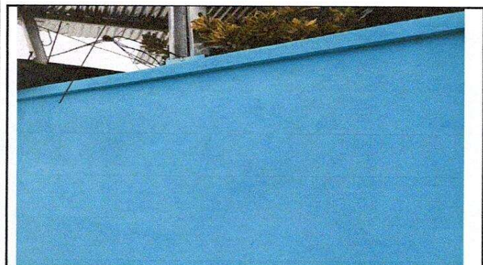
Foto 9: Sustitución de pintura en muro exterior
