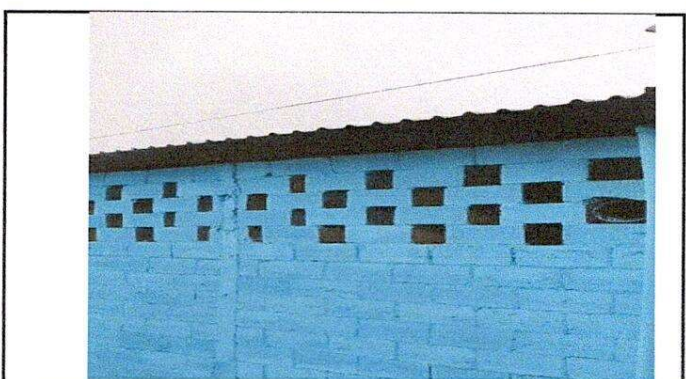
Foto 10: Sustitución de pintura en pared exterior
