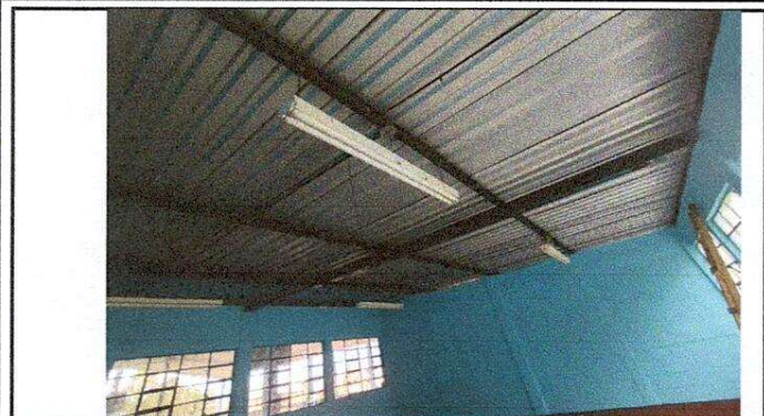
Foto7: Sustitución de sistema electrico
