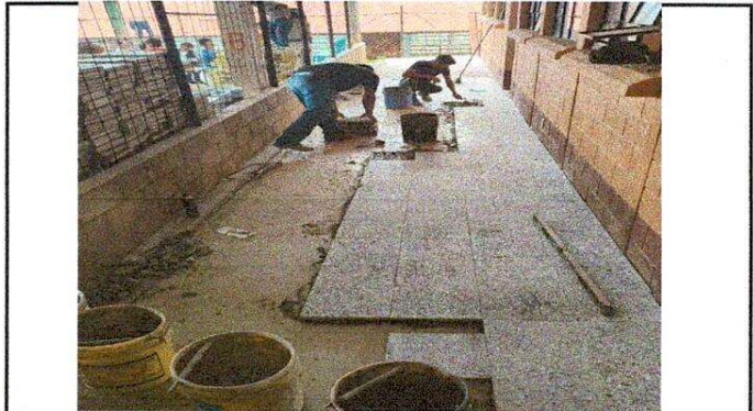
Foto 2: Sustitución de piso de torta por piso granito
