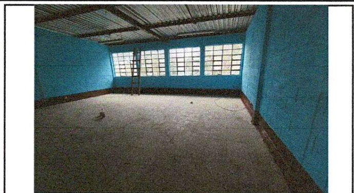
Foto 8: Sustitución de sistema eléctrico
