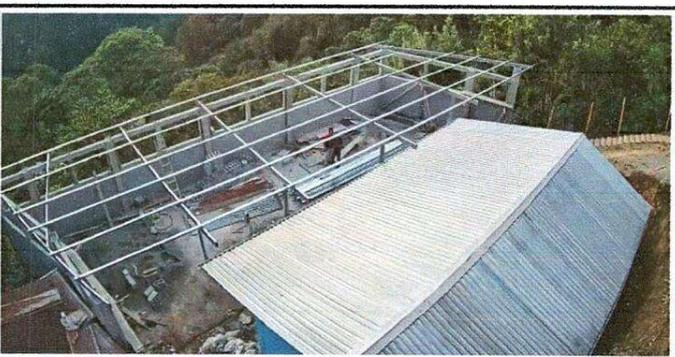
Foto 5. Culminación de soporte de madera por soporte de metal
