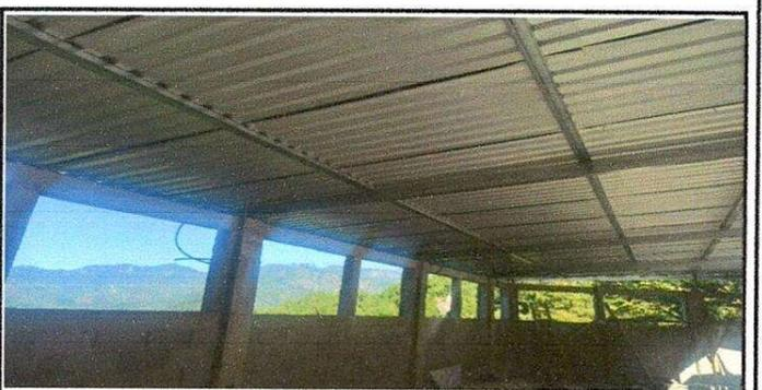
Foto 6. Culminación de soporte de madera por soporte de metal
