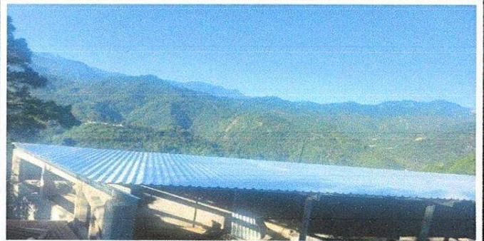
Foto 2. Avance de Sustitución de lámina por lamina troquelada
