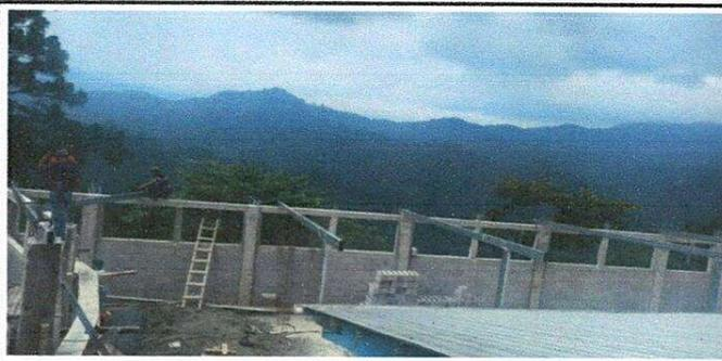
Foto 5. Adelanto de soporte de madera por soporte de metal
