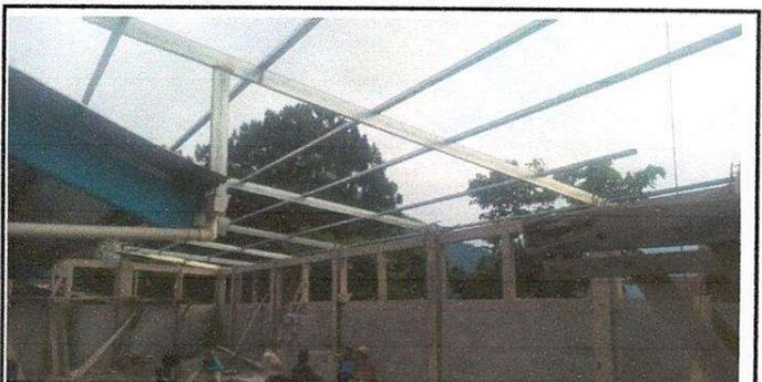
Foto 6. Adelanto de soporte de madera por soporte de metal
