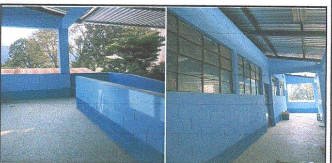
Foto 6: pintura en muros interiores y exteriores
