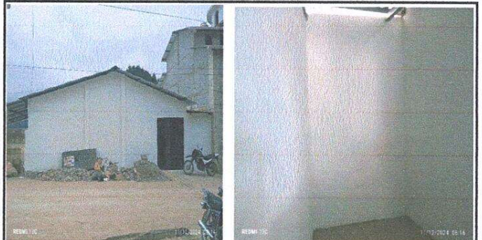
Foto 2: Reparación de muro perimetral de block
