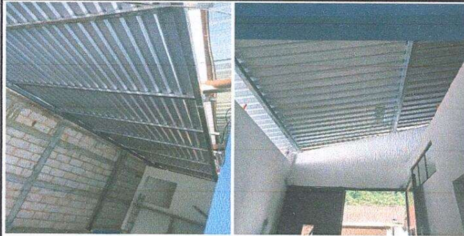
Foto1: Sustitución de lamina por lámina troquelada
