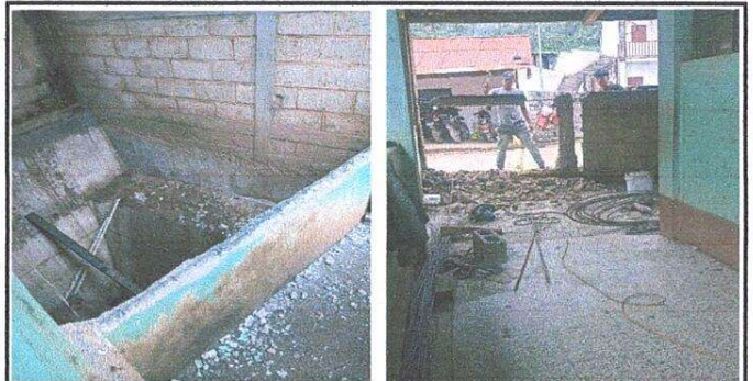
Foto 2: Reparación de muro Perimetral de block
