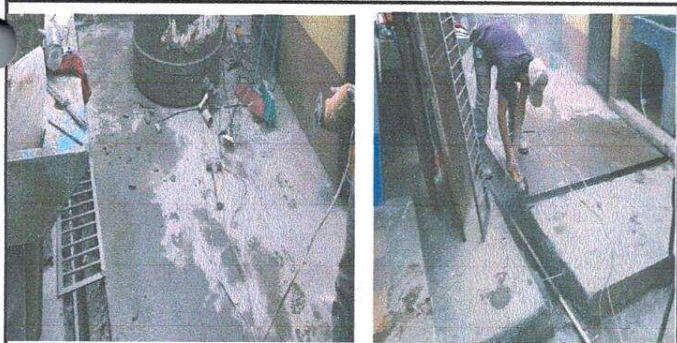
Foto 5: reparación de red de drenaje y tubería
