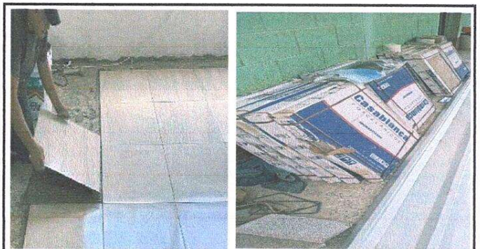
Foto 4: Sustitución de piso torta de concreto por cerámico
