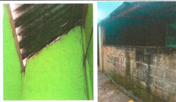
Foto 6: pintura en muros interiores y exteriores
