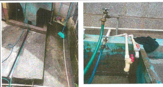
Foto 5: reparación de red de drenaje y tubería
