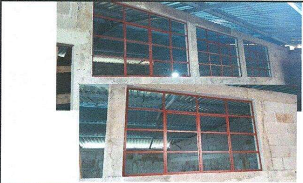
Foto 9: Estructura de metal realizada
