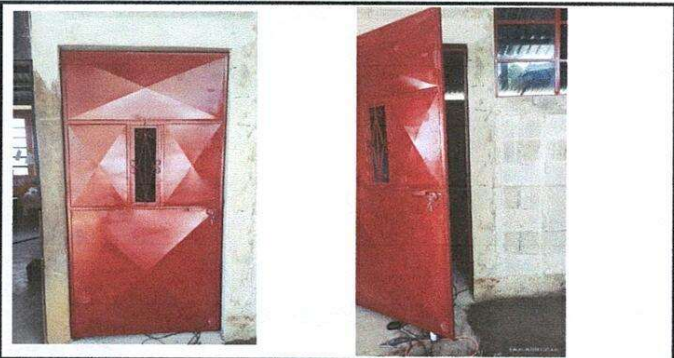
Foto 5: Puerta de aula instalado
