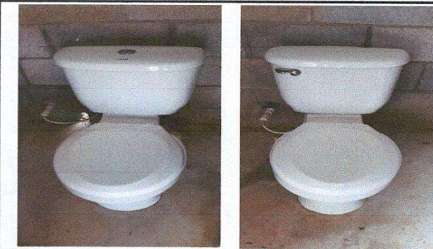
Foto 11: Tazas de sanitarios instalados
