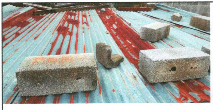
Foto 3: Módulo de aula está improvisado el techo no tiene sujetadores
