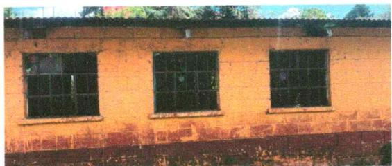
Foto 9: Estructura de metal de ventanas en malas condiciones
