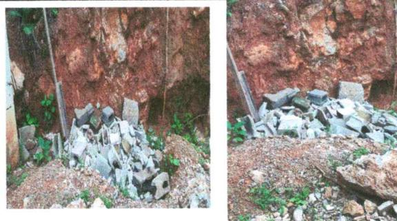
Foto 12: Muro de contención se desplomó
