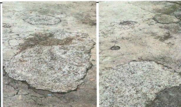
Foto 10: Piso del módulo de aula en malas condiciones
