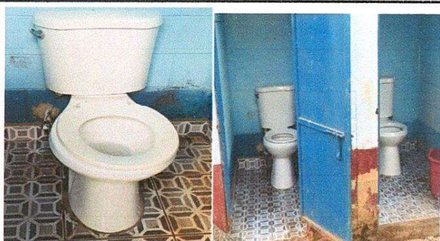
Foto 3: Sustitución de inodoro en baño
