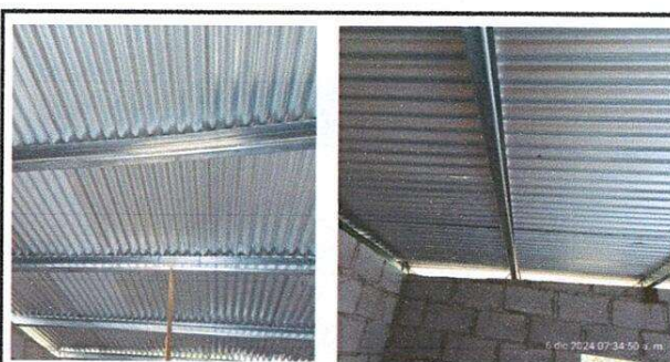
Foto 6: Sustitución de estructura de metal de techo.
