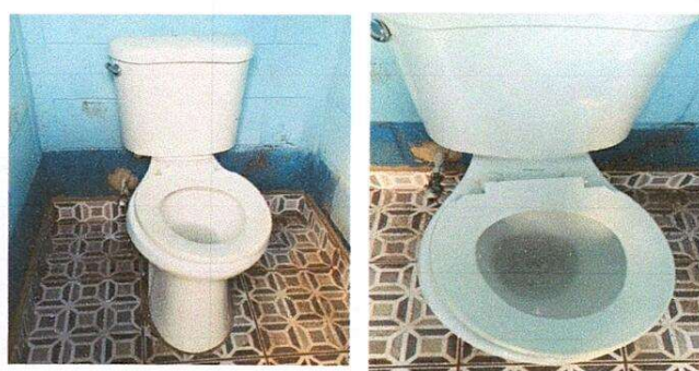
Foto 2: Sustitución de accesorios en taza de baño.
