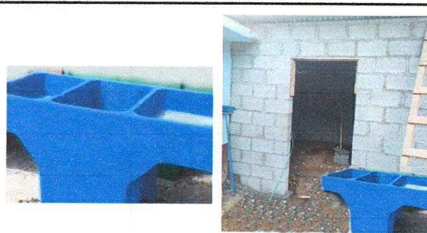
Foto 4: Sustitución de pila de concreto.
