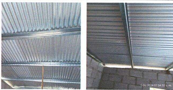
Foto 6: Sustitución de estructura de metal de techo.
