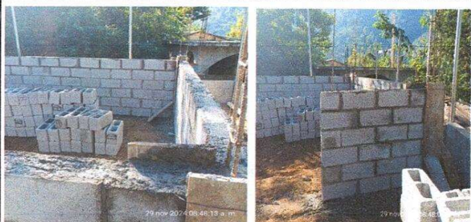
Foto 5: Sustitución de pared de lámina por pared de block.
