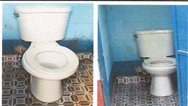
Foto 3: Sustitución de inodoro en baño
