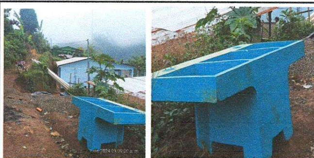
Foto 4: Sustitución de pila de concreto.
