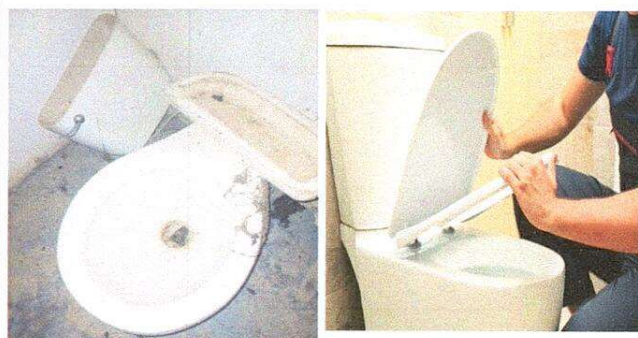
Foto 2: Sustitución de accesorios en taza de baño.
