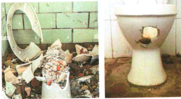
Foto 3: Sustitución de inodoro en baño
