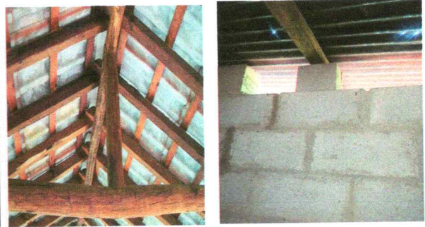
Foto 6: Sustitución de estructura de metal de techo.
