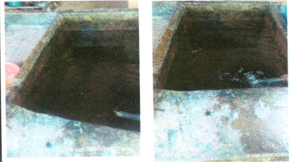
Foto 4: Sustitución de pila de concreto.
