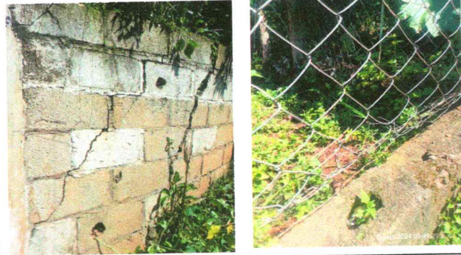
Foto1: Reparación de muro perimetral de block, tubo hg, malla galvanizada, soleras intermedias y columnas.
