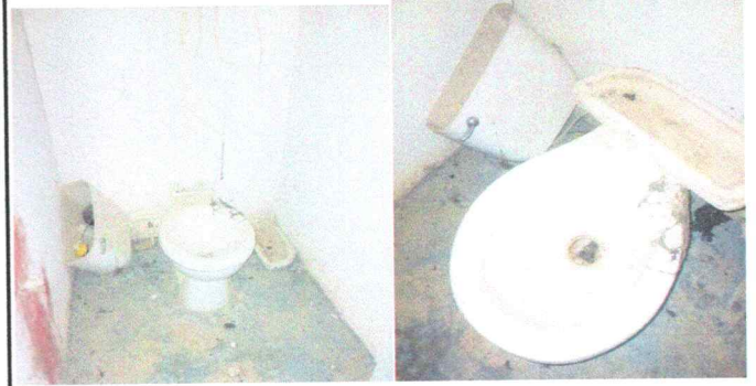
Foto 2: Sustitución de accesorios en taza de baño.
