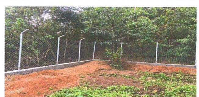
Foto 6: Muro y circulación perimetral
