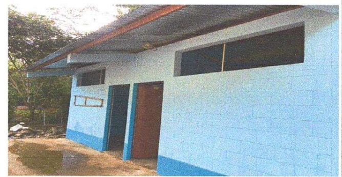
Foto 4: Pintura de pared en sanitarios
