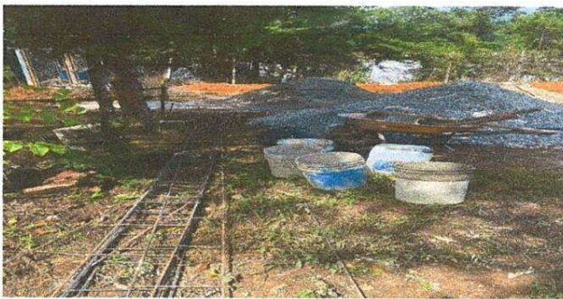
Foto 3: Armadura de columna para muro perimetral
