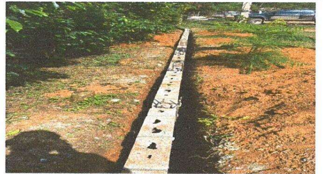
Foto 4: hiladas de block bajo el suelo para muro
