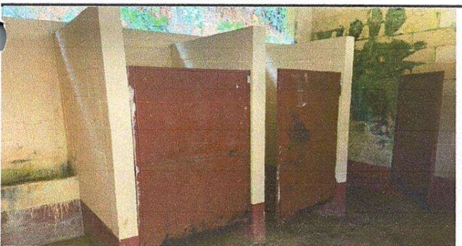
Foto 5. lijado de puertas; pintura en puertas y pared
