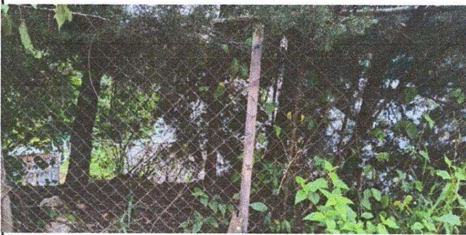
Foto 3: Cercado en mal estado
