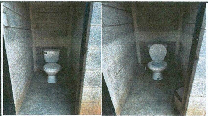
Foto 3: Colocación de las 2 tasas de baño.
