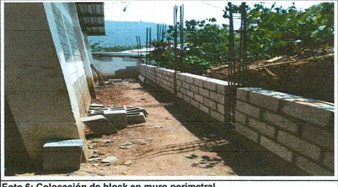
Foto 6: Colocación de block en muro perimetral.
