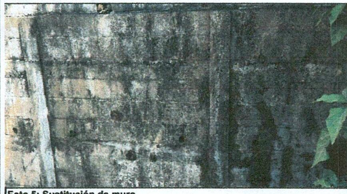
Foto 5: Sustitución de muro
