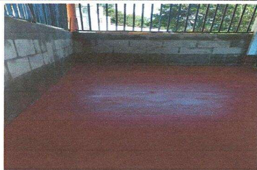
Foto 6: Sustitución piso torta por piso cerámico.
