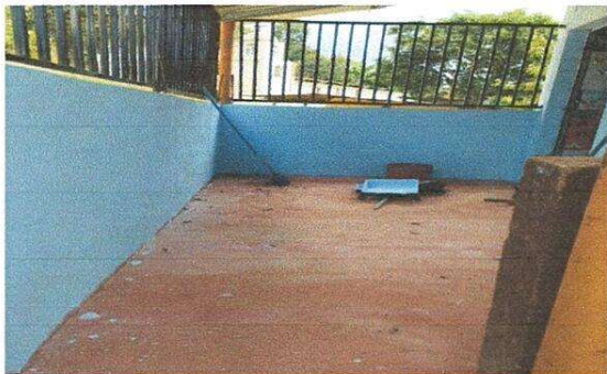
Foto 1: Construcción de muro
