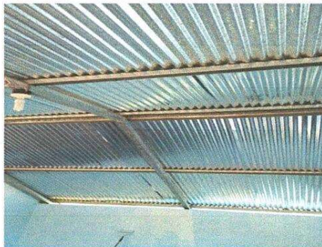
Foto 2: Sustitución de techo costaneras y láminas troqueladas calibre 26.
