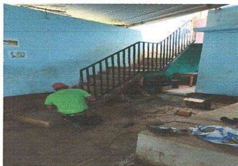
Foto 5: Mantenimiento de baranda.
