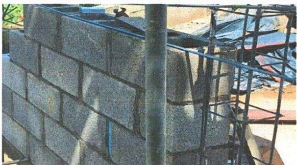
Foto1: Construcción de muro
