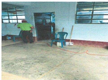
Foto 3: Sustitución de puerta
