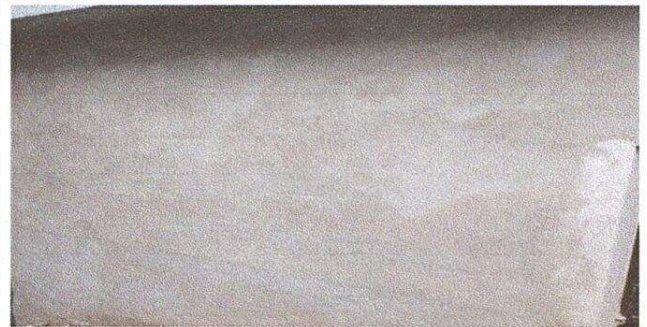
Foto 6: Repello de muro
