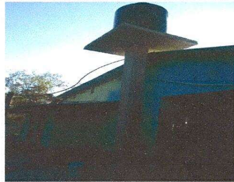
Foto 4: Reforzamiento de la base del tinaco
