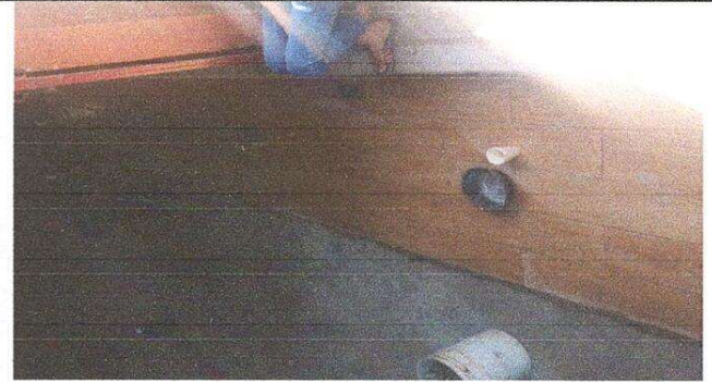
Foto 2: colocacion de duela de ceramico
