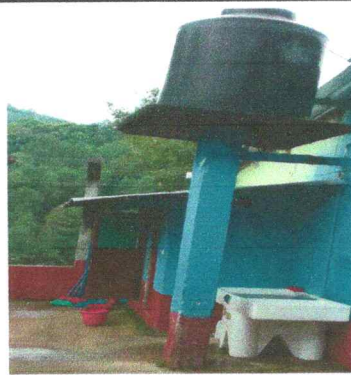
Foto 4: Mejoramiento de base de tinaco
