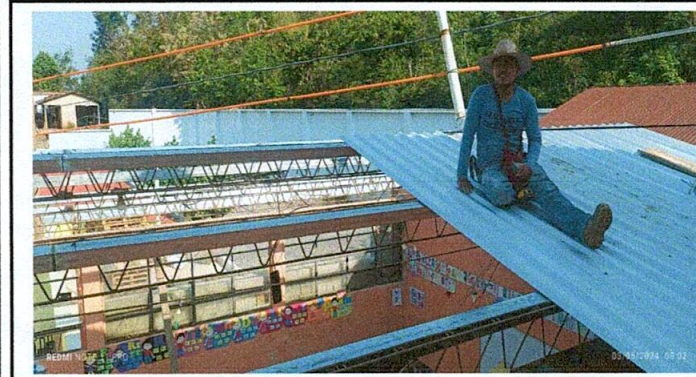
Foto1: Sustitución de lámina por lámina troquelada
