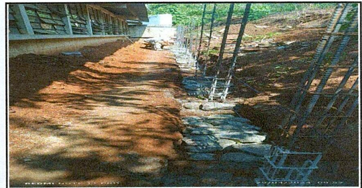
Foto 6: Reparación de muro perimetral de block
