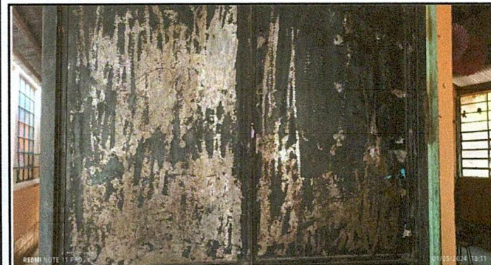
Foto 3: Mantenimiento de estructura
