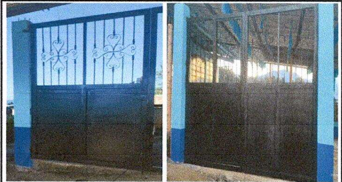
Foto 2: Portón finalizado e instalado
