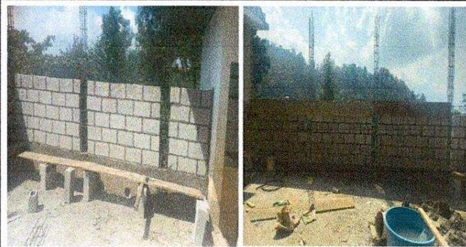
Foto 3: Proceso de construcción del muro perimetral con hiladas de block en su totalidad
