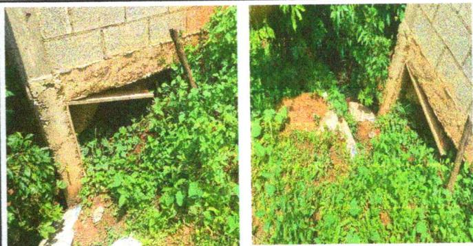
Foto 4: Muro de contención que se está derrumbando por las fuertes lluvias
