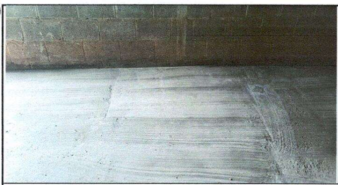
Foto 5: reparación de planchas de concreto de patio
