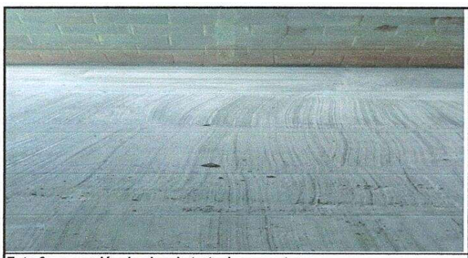
Foto 6: reparación de piso de torta de concreto
