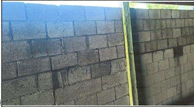
Foto 1: reparación de muro perimetral de block
