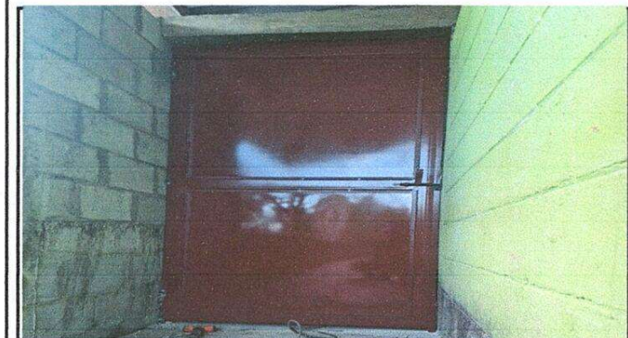
Foto 3: sustitución de puerta
