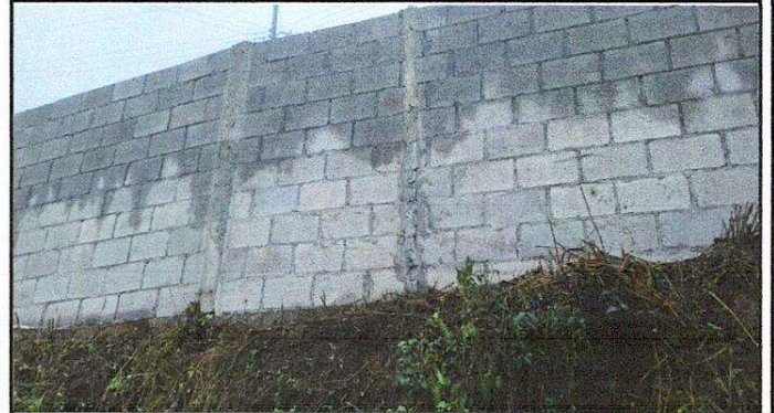
Foto 2: reparación de muro perimetral de block
