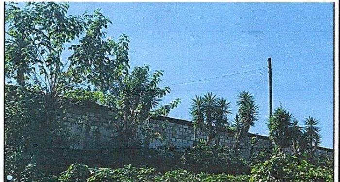
Foto 4: reparación de muro perimetral de block
