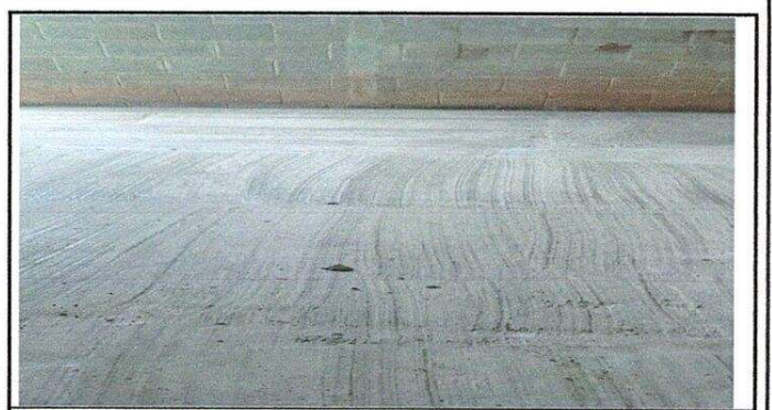
Foto 6: reparación de planchas de concreto de patio
