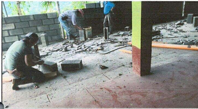
Foto 1: reparación de muro perimetral de block
