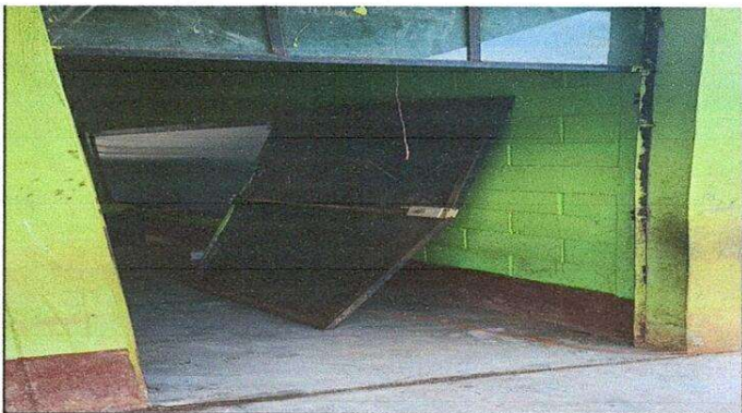
Foto 4: sustitución de puerta
