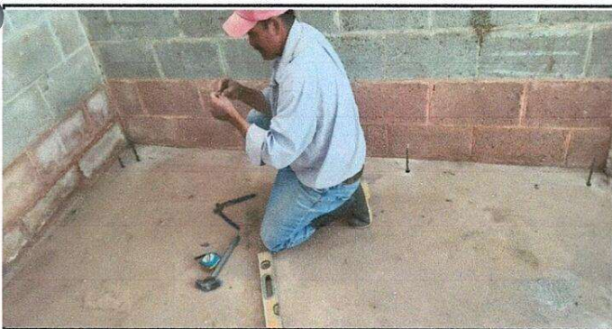
Foto 5: reparación de piso de torta de concreto
