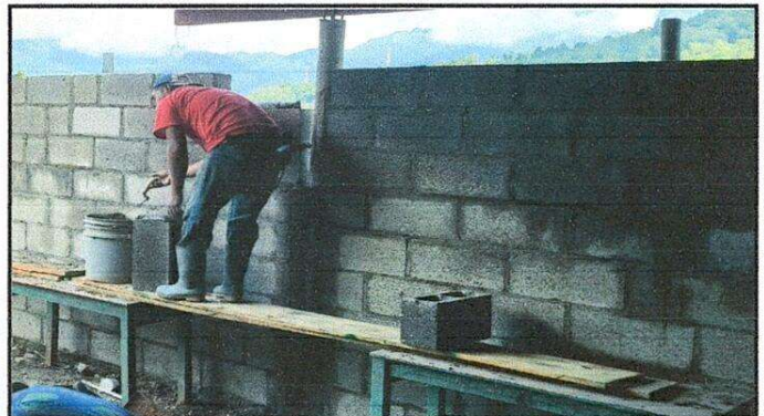
Foto 2: reparación de muro perimetral de block
