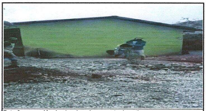
Foto 6: reparación de planchas de concreto de patio
