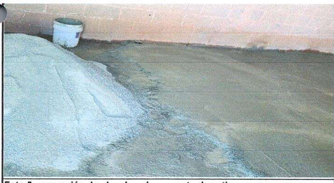
Foto 5: reparación de planchas de concreto de patio
