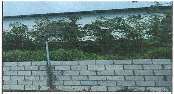
Foto 4: reparación de muro perimetral de block
