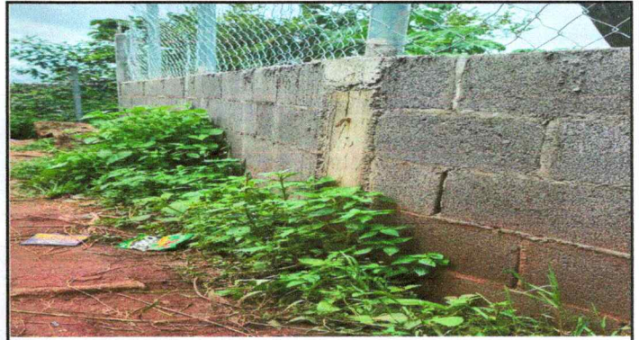
Foto 8: reparación de muro perimetral de block
