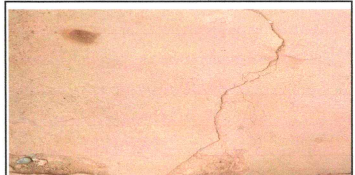
Foto 12: reparación de piso de torta de concreto
