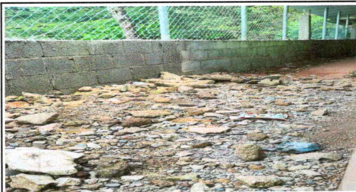
Foto 9: reparación de muro perimetral de block
