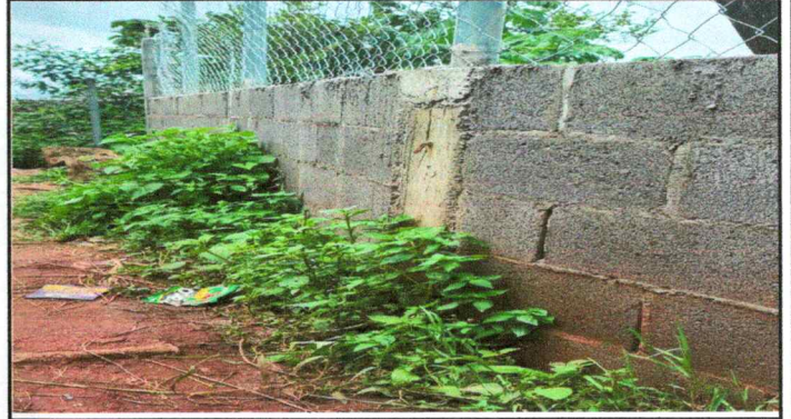
Foto 14: repello en muro
