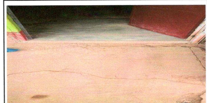
Foto 6: reparación de piso de torta de concreto
