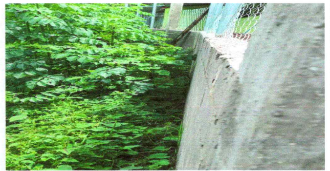
Foto 10: reparación de muro perimetral de block
