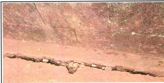
Foto 11: reparación de planchas de concreto de patio
