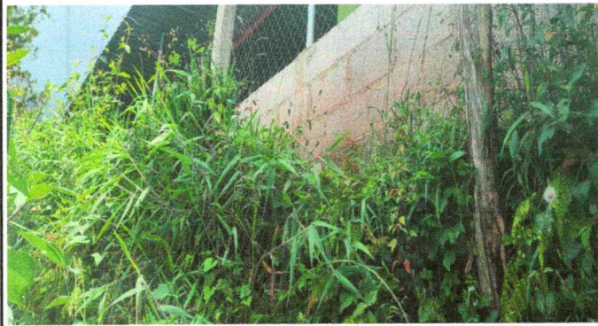
Foto 7: reparación de muro perimetral de block
