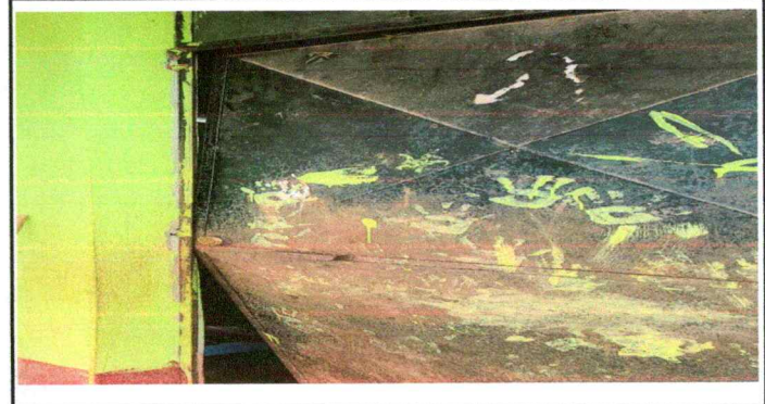
Foto 4: sustitución de puerta
