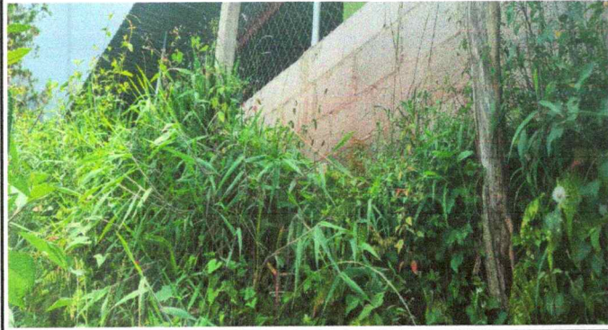
Foto 13: repello en muro
