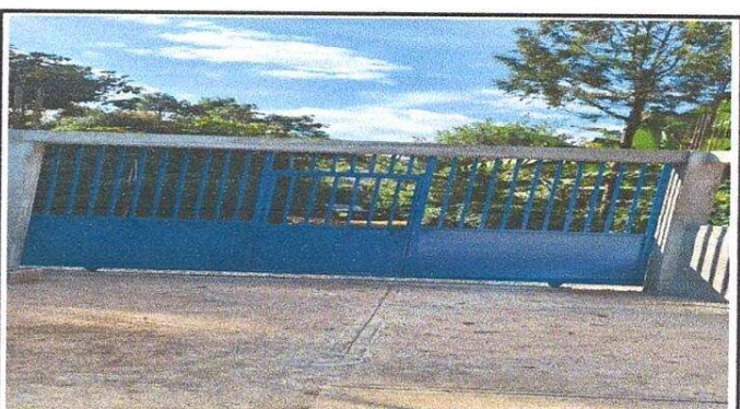
Foto 4: Cambio de portón de ingreso.
