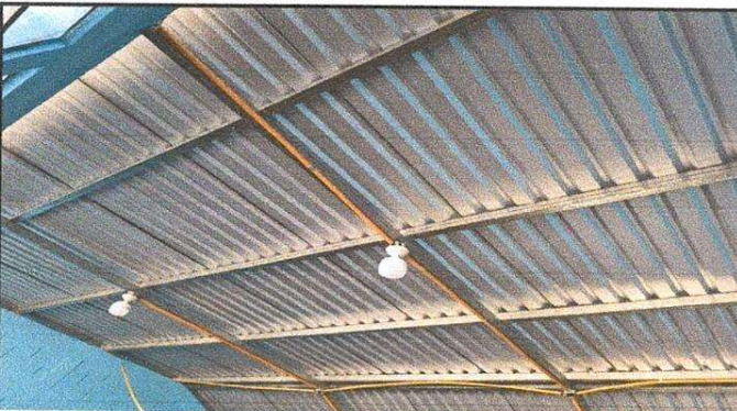
Foto 3: Mantenimiento y reparación de energía eléctrica.
