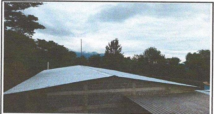
Foto 4: Colación de lámina troqueleada.
