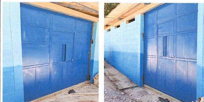
Foto 3: Cambio de portón de malla por portón de metal
