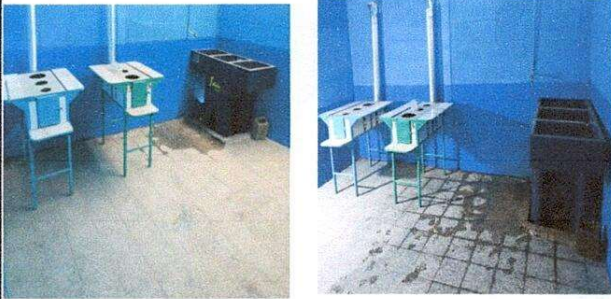
Foto1: Sustitucion de planchas y pila plástica
