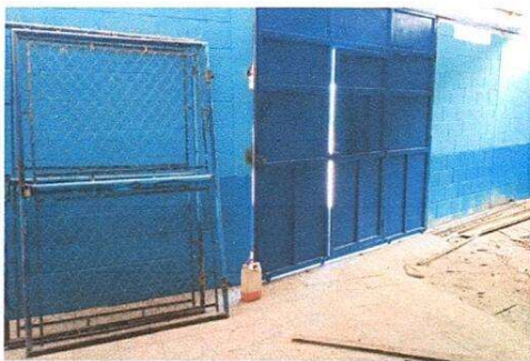
Foto 5: Cambio de portón de malla por portón de metal
