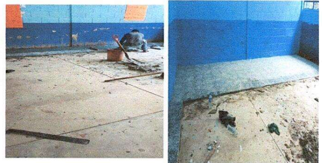
Foto 4: Cambio piso de torta de cemento por piso de granito
