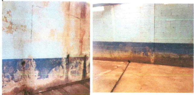
Foto 2: pintura en muros exteriores e interiores
