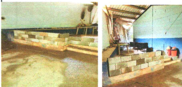
Foto 5: Reparación de pared cocina
