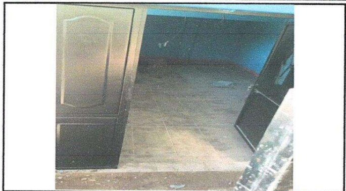
Foto 2: pintura de muros interiores y exteriores
