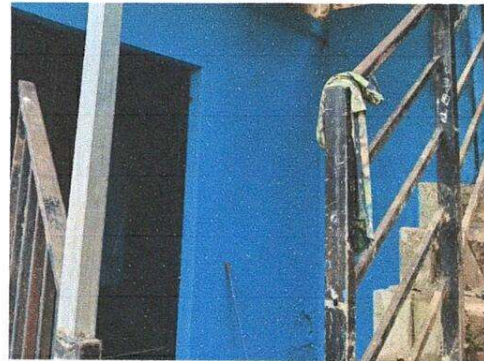
Foto 8: mantenimiento de barandas
