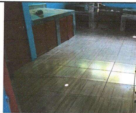
Foto 12: reparación de cocina
