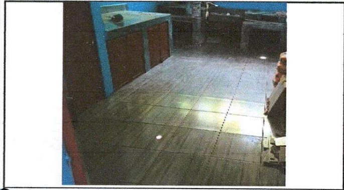
Foto 1: sustitucion de piso cerámicos, azulejo y planchas
