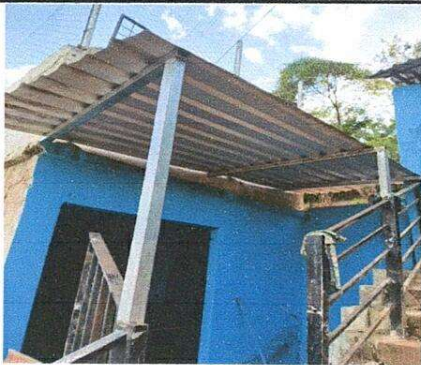
Foto 7: sustitucion de techo por lámina troquelada calibre 26
