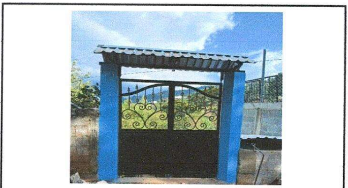
Foto 4: Sustitucion de portón
