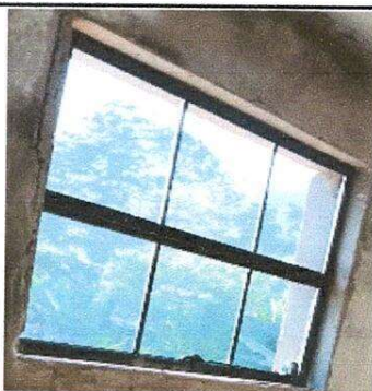
Foto 11: sustitución de ventanas de madera por metal
