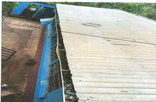
Foto 3: sustitución de canal por tubo PVC
