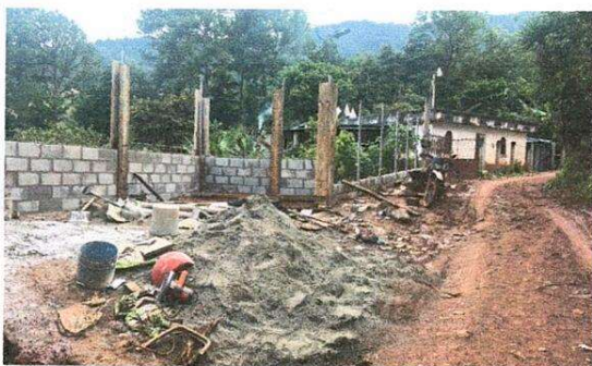
Foto 9: sustitución de muro perimetral blok con tubo HG maya galvanizada, soleras intermedias y columnas
