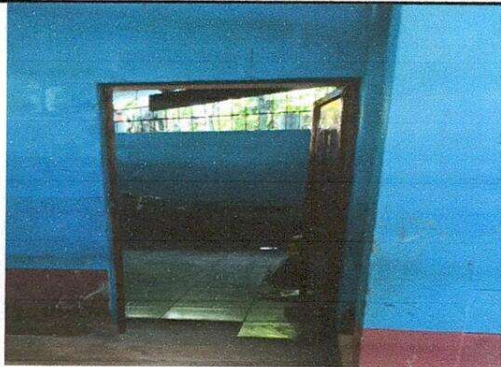
Foto 1: colocación de cerámica en cocina
