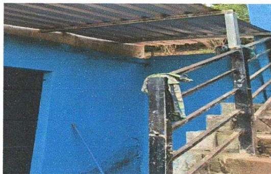
Foto 8: mantenimiento de barandas
