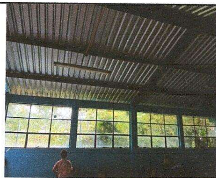
Foto 6: reparación de sistema eléctrico
