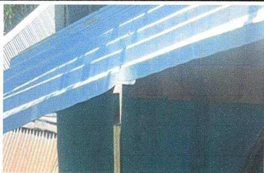
Foto 7: sustitución de techo por lámina troquelada calibre 26
