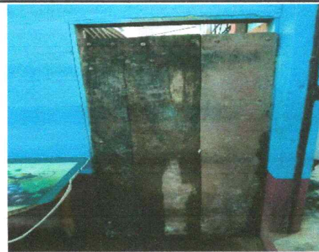
Foto 4: PUERTAS DE METAL
