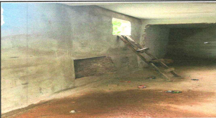
Foto 3: PINTURA EN MUROS EXTERIORES E INTERIORES
