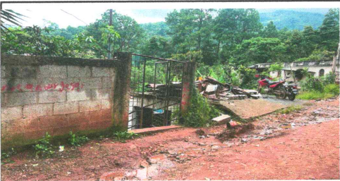
Foto 5: MANTENIMIENTO A PORTONES
