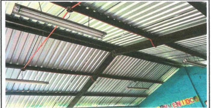
Foto 6: REPARACION DEL SISTEMA ELECTRICO
