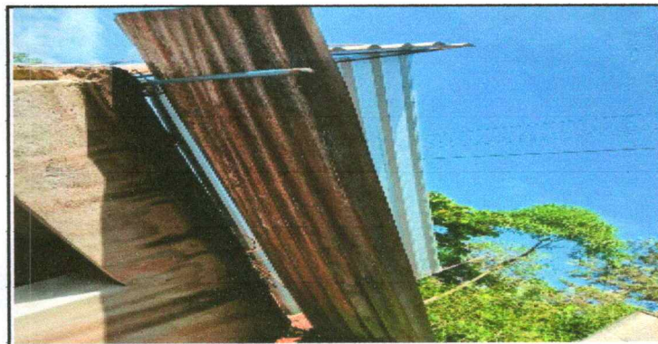
Foto 10 CUBIERTA DE LAMINA
