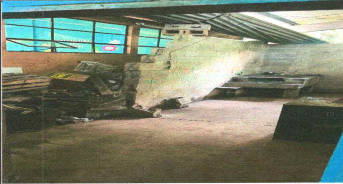
SUSTITUCION DE PISO CERAMICO
