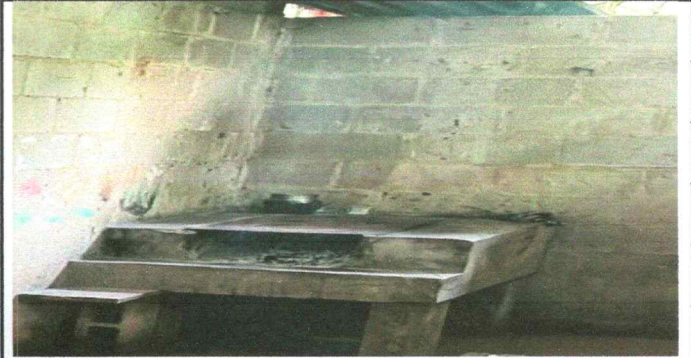
Foto 2 REPARACION DE COCINA
