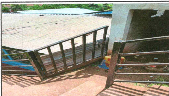
Foto 7 MANTENIMIENTO A BARANDAS
