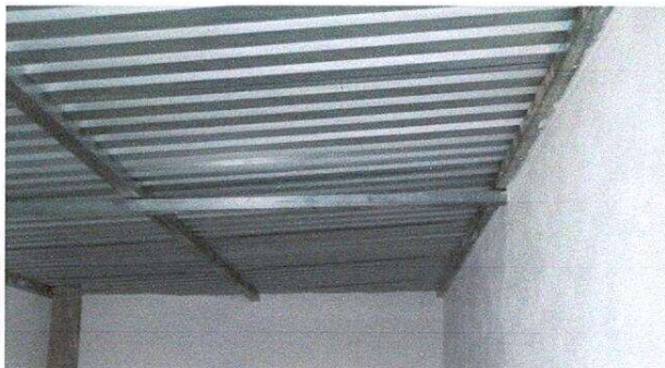
Foto1: Estructura de techo de metal
