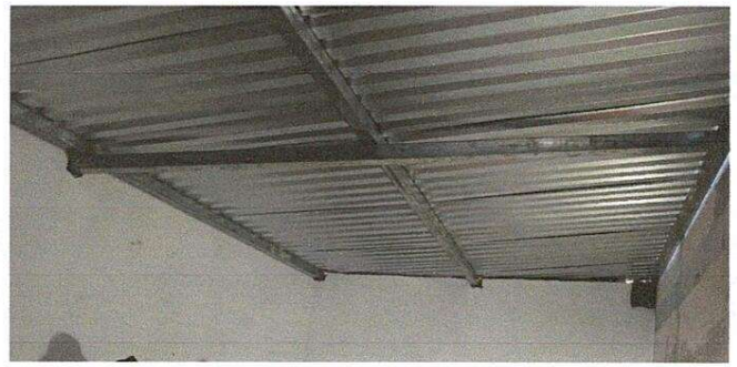
Foto 4: Techo de lamina troquelada
