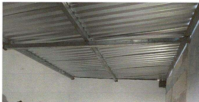
Foto 2: Estructura de techo de metal
