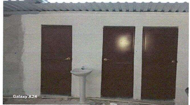
Foto 14: Puerta de servicio sanitario
