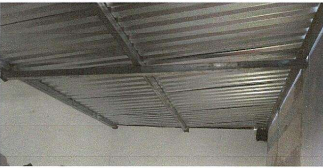
Foto 3: Techo de lamina troquelada
