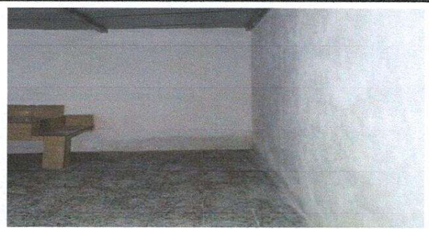
Foto 6: Muro perimetral de block
