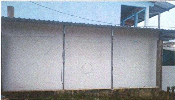
Foto 5: Muro perimetral de block
