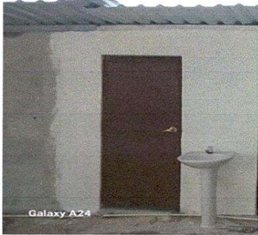
Foto13: Puerta de servicio sanitario
