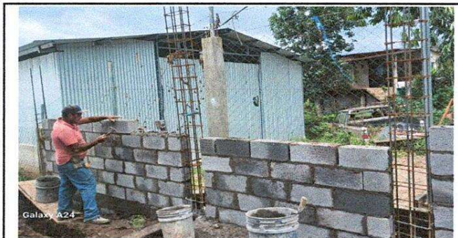
Foto 5: Reparación de muro perimetral de block (en cocina)
