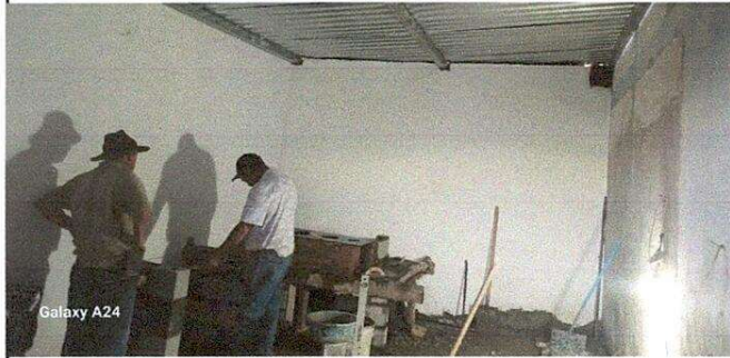
Foto1: Reparación de cocina
