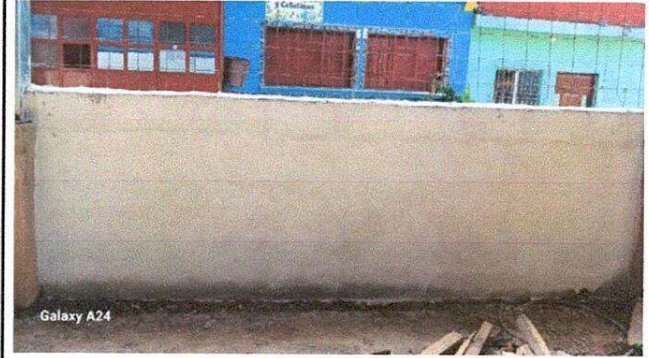
Foto 26: Reparacion de muro perimetral.
