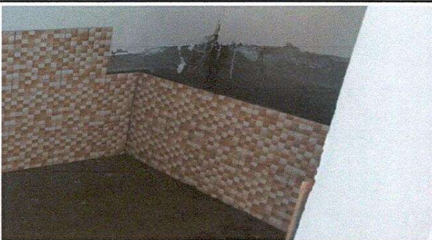
Foto 17: Sustrucción de mingitorio
