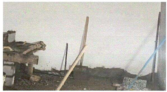
Foto 10: Sustrucción de piso
