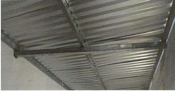
Foto 7: Sustrucción de estructura
