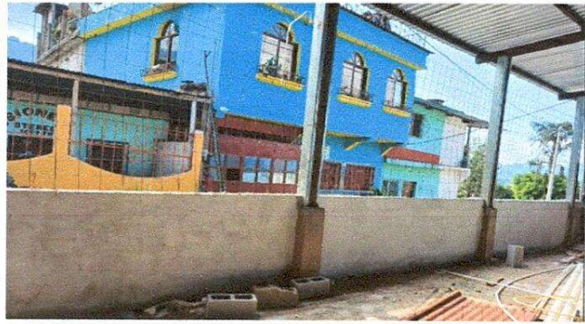
Foto 25: Reparacion de muro perimetral.
