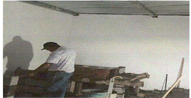
Foto 2: Reparación de cocina
