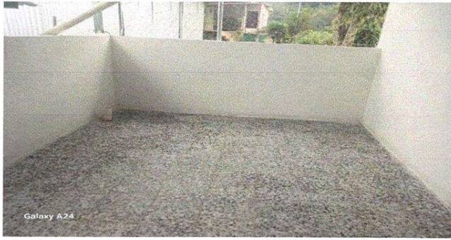
Foto 19 : Sustrucción de pila de cemento
