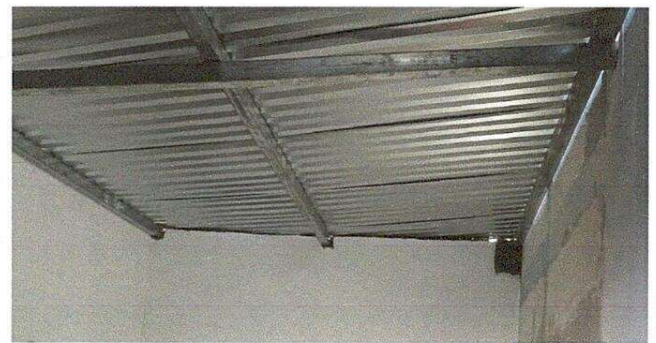
Foto 4: Cubierta de lámina
