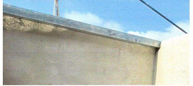
Foto 8: Sustrucción de estructura
