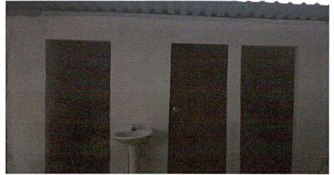
Foto 14: Sustrucción de puerta de metal en servicio sanitario
