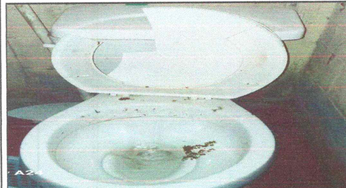
Foto 15 : Sustitución de Inodoro
