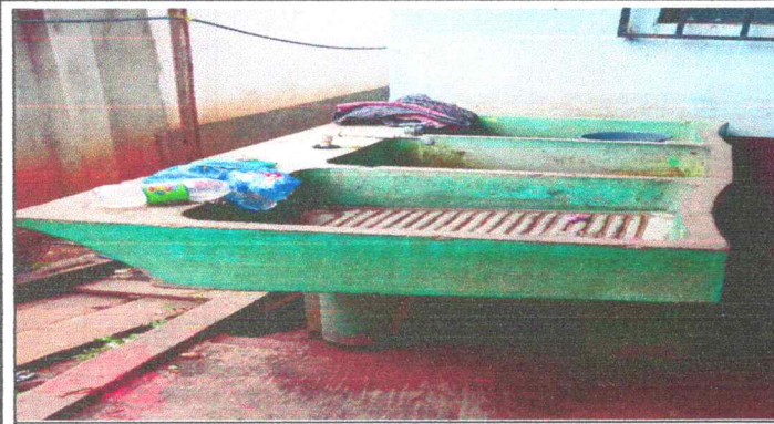
Foto 19 : Sustitución de pila de cemento de dos lavaderos
