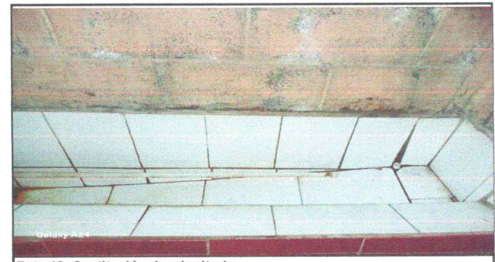
Foto 18: Sustitución de mingitorio
