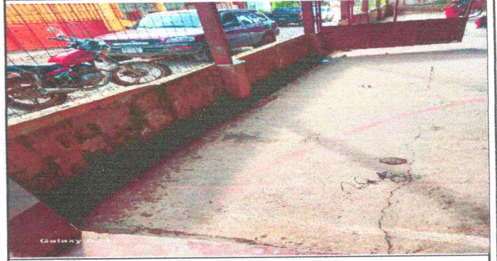
Foto26 : Sustitución de muro perimetral
