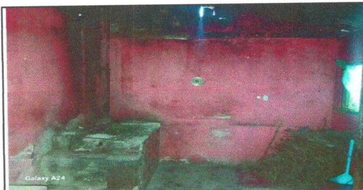
Foto 5: Reparación de muro perimetral de block
