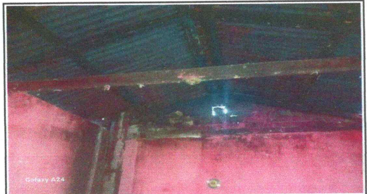
Foto 4: Cubierta de lámina
