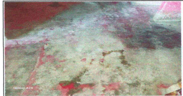
Foto 10: Reparación de piso de cemento
