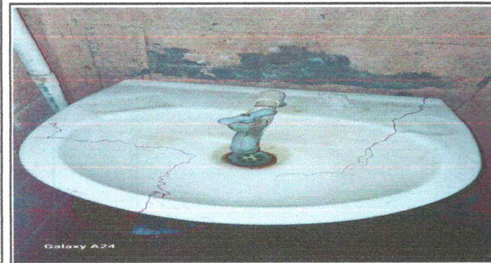
Foto 21 : Sustitución de lavamanos
