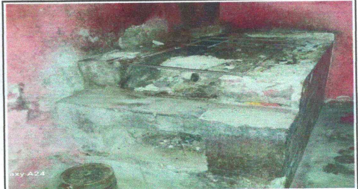
Foto 2: Reparación de cocina
