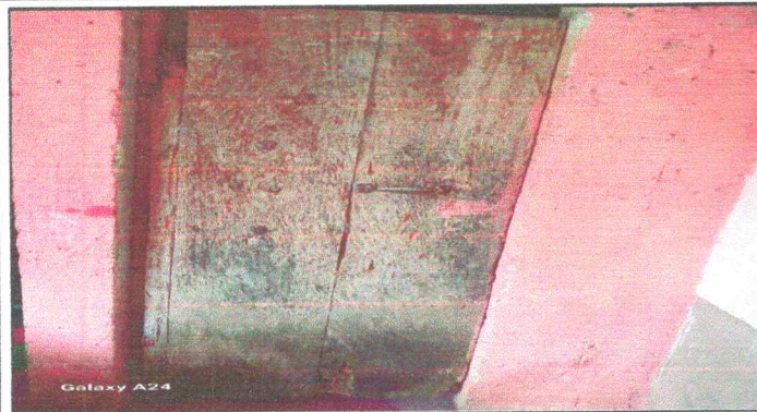
Foto13 : Reparación puerta del baño
