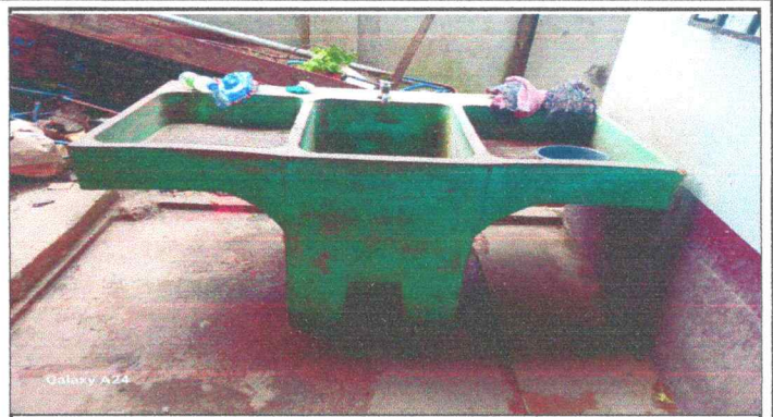
Foto 20 : Sustitución de pila de cemento de dos lavaderos
