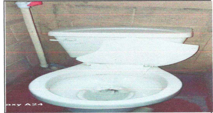
Foto 16 : Sustitución de Inodoro
