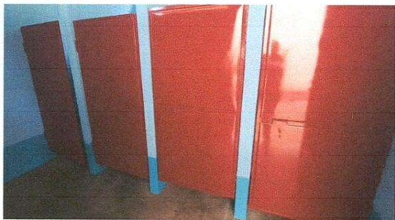
Foto 5: Puertas de baños finalizada
