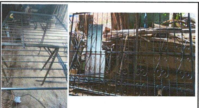
Foto 4: Avance del balcón
