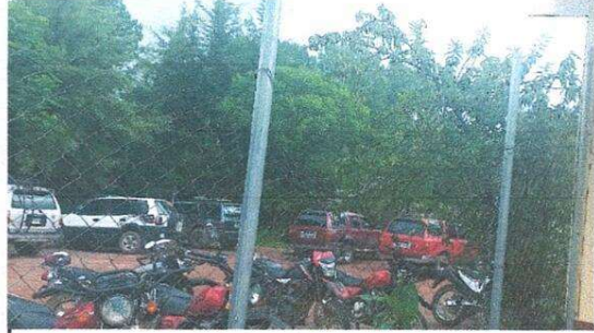
Foto 2: Tubo y malla en mal estado
