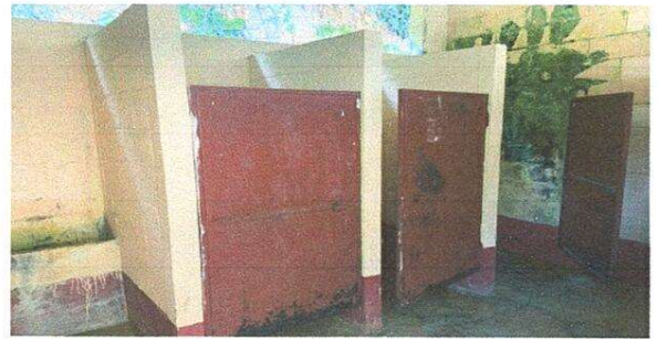
Foto 2: Sustitución de puertas de metal
