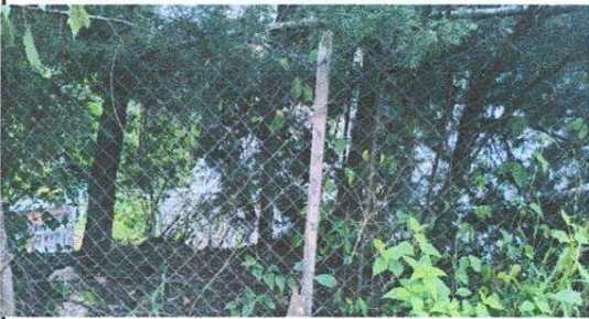
Foto 3: Cercado en mal estado
