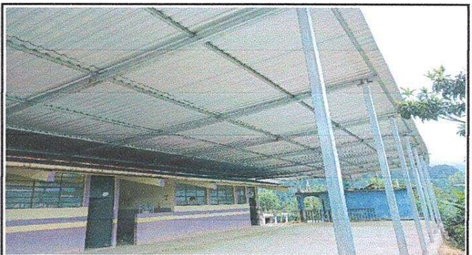
Foto 4: Vista de la fase final de la estructura metálica y laminas ya colocadas en su lugar
