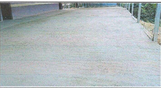
Foto 5: Torta de concreto lista para su uso.
