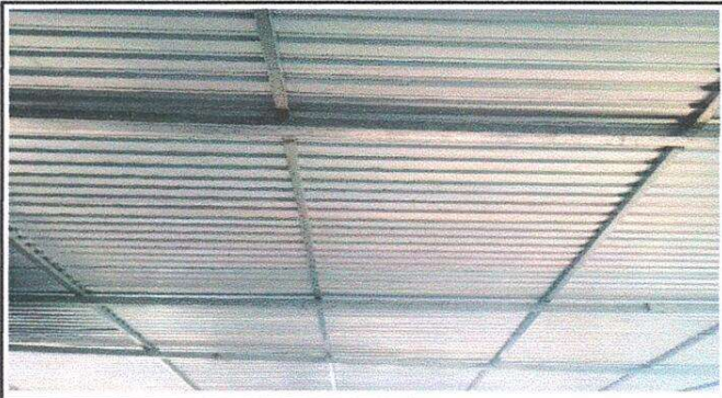
Foto1: Estructura metálica debidamente colocada y soldada sosteniendo las laminas.
