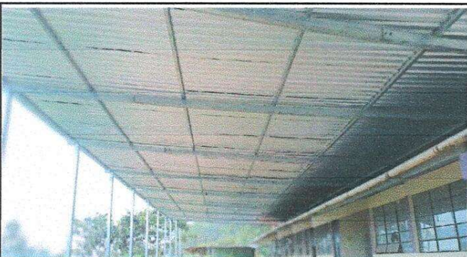
Foto 3: Laminas ya colocadas en su fase terminal.
