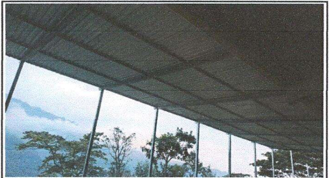
Foto 2: Estructura metálica como base de soporte ya instalada.
