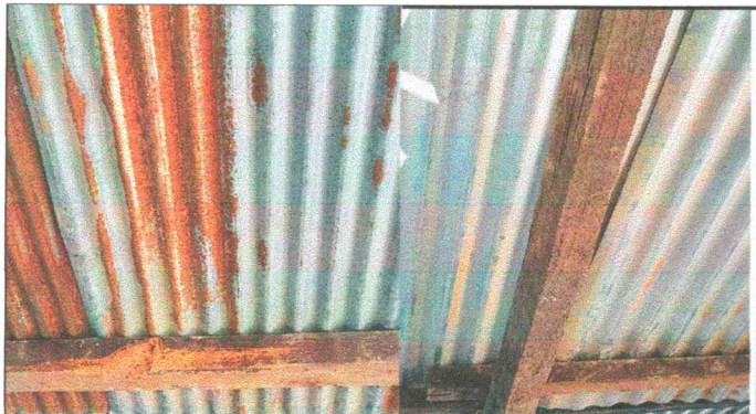
Foto 3: Soporte de madera que necesita cambiarse por seguridad de los alumnos.
