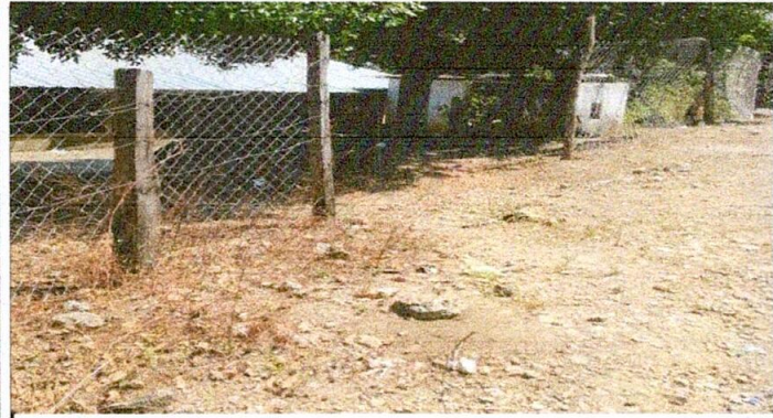
Foto 1: Reparación de muro perimetral de block de 5 hiladas con tubo hg y malla galvanizada (Entrada al establecimiento)
