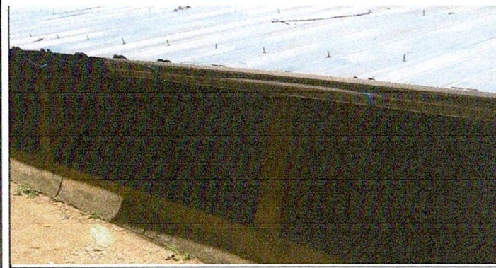
Foto 5: Sustitución de canal de pvc
